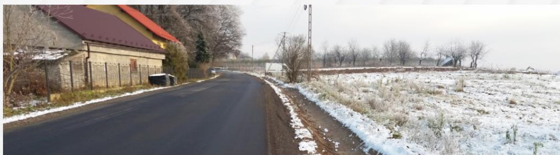
Nowa nawierzchnia na drodze powiatowej w Goszczy
