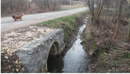
Rawałowice - remont przepustu
