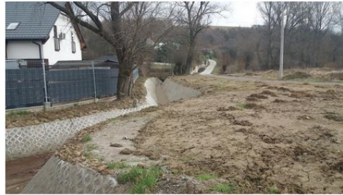
Wiktrowice - przebudowa rowu odwadniającego
