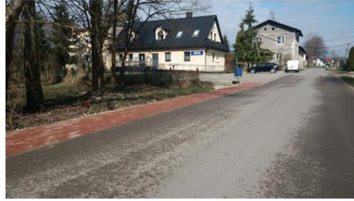
Skrzeszowice - utwardzenie pobocza
