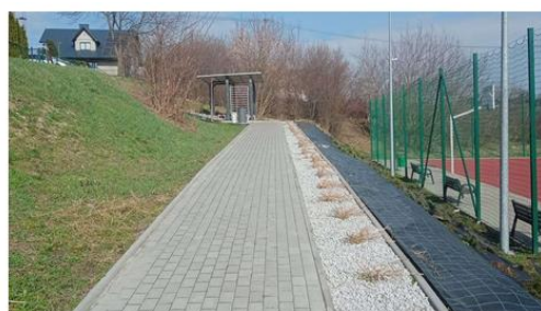
Luborzyca - utwardzenie dojścia do altany
