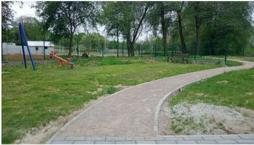
Sulechów - budowa siłowni plenerowej
