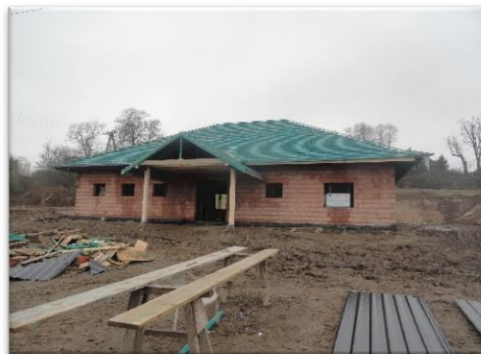
Budowa obiektu w Dojazdowie
