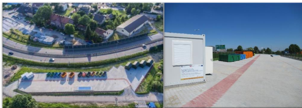
Punkt Selektywnej Zbiórki Odpadów Komunalnych
