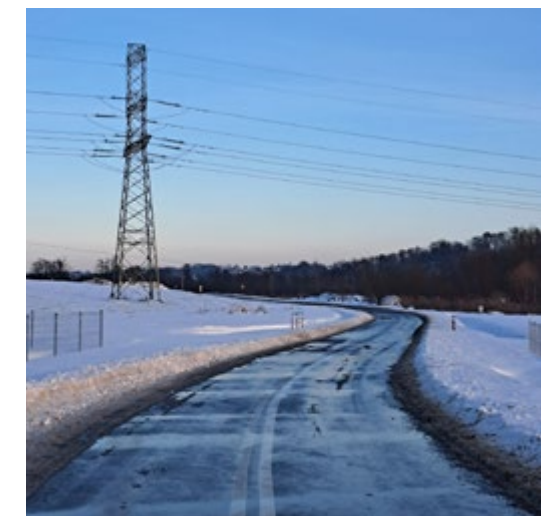
Inwestycja w Zastowie
